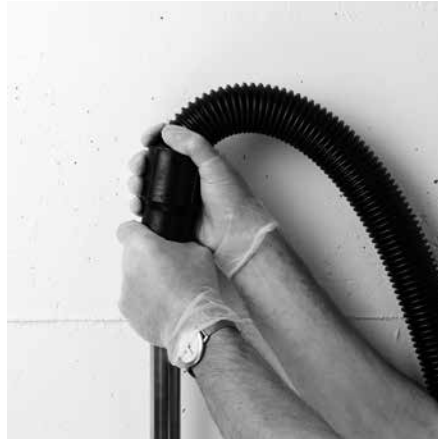
Einsaugen der Einzughilfe in der obersten Wohnung beim Verteiler von unten nach oben.
