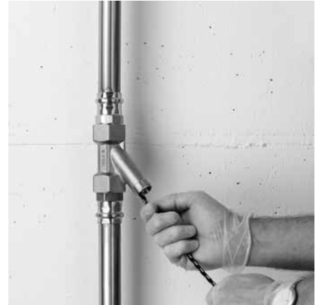
Einführen der Einzughilfe während dem Ansaugen.
