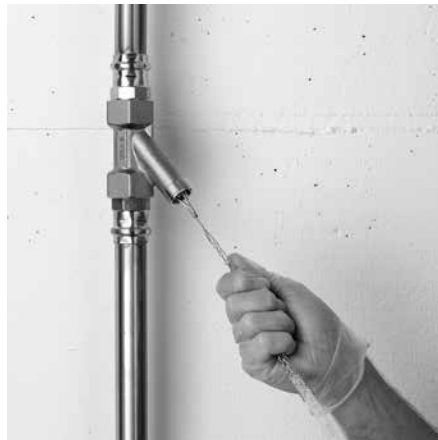
Überstülpen der Einzughilfe (Kupplungsstück) auf das Kunststoffrohr.
