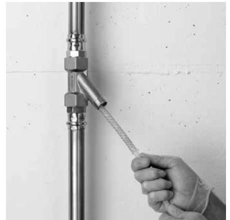
Einziehen des Kunststoffrohres.
