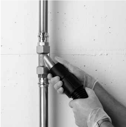
Einsaugen der Einzughilfe beim Formstück von oben nach unten.
