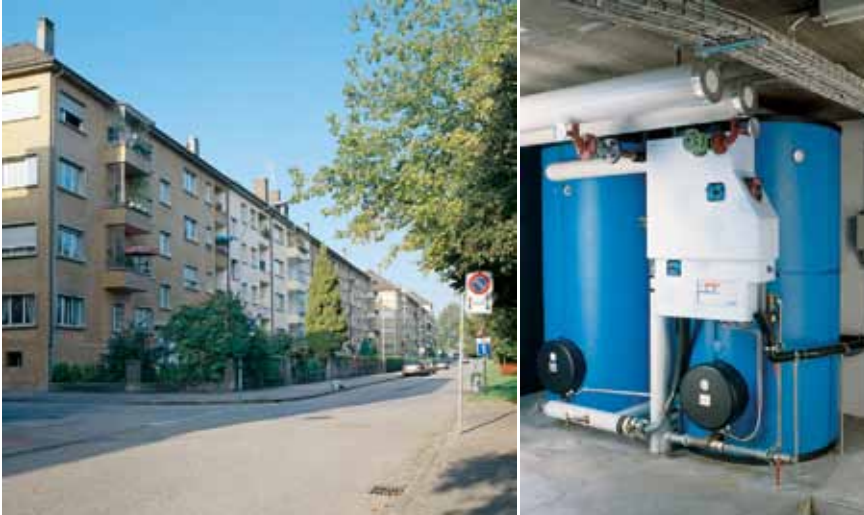
Planification: Max Bein, bureau d'ingénieur, Oberdorf / Exécution: Sulzer Infra SA, Soleure
