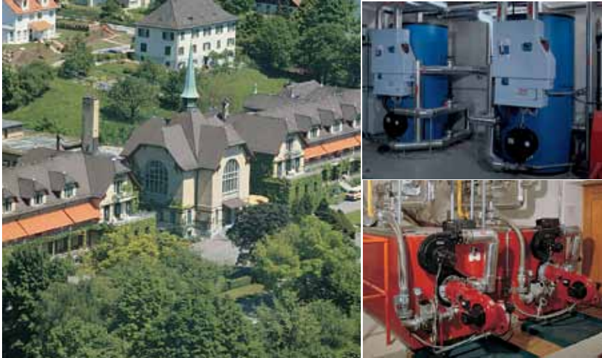
Planification: Schneider & Aebi, Soleure / Exécution: Lehmann & Billeter AG, Meilen
