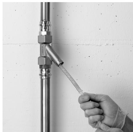
Infilamento del tubo di plastica.
